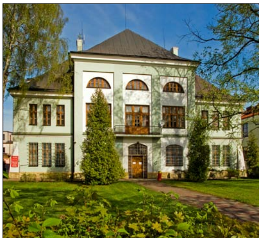
Budynek dawnego sejmiku powiatowego
