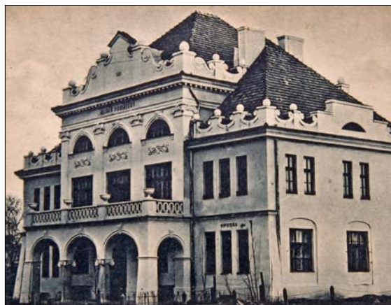
Budynek dawnego sejmiku powiatowego
