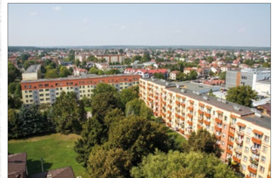
Bloki przy ulicach Kościuszki i Jana Pawła II (widok z wieży kościoła pw. NSPJ)
