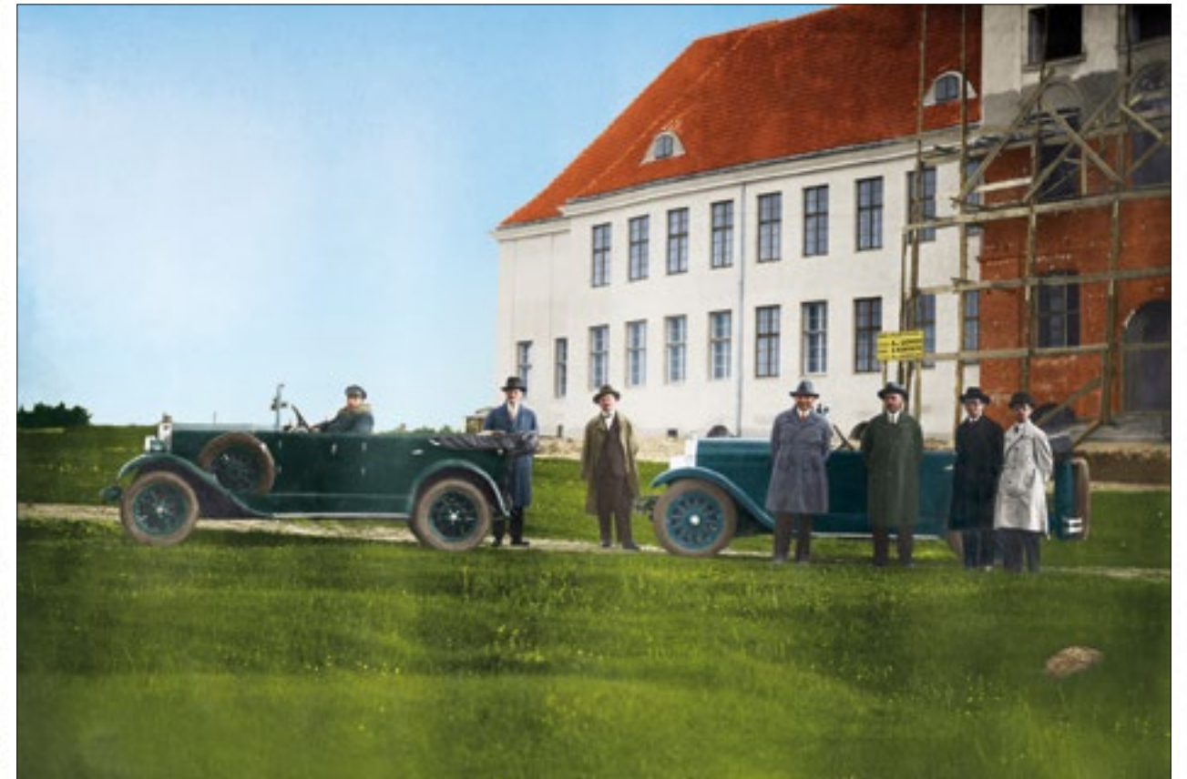
Kurator Okręgu Szkolnego w Lublinie dr Eustachy Nowicki wizytuje budowę Gimnazjum im. Bartosza Głowackiego, 1929
