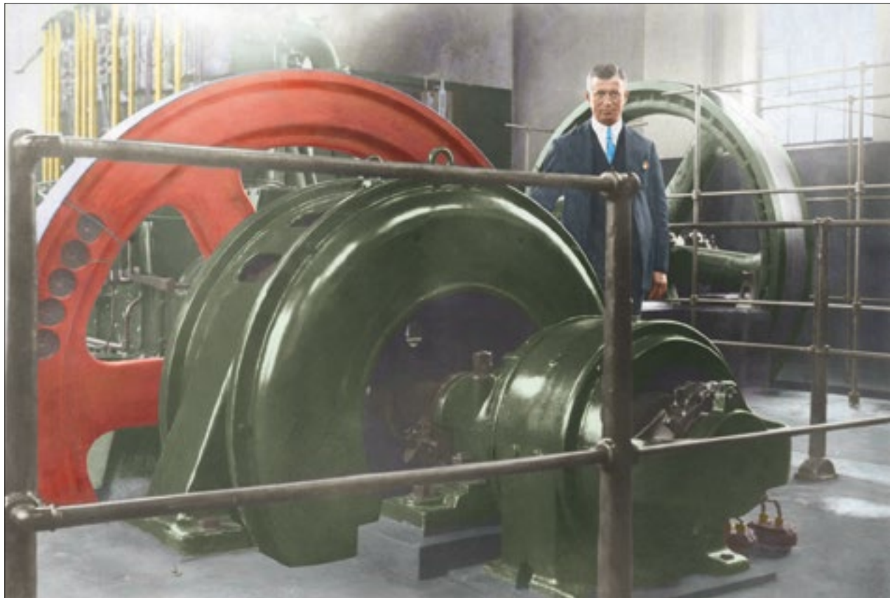
Inżynier Trzaskowski przy generatorze prądotwórczym w miejskiej elektrowni mieszczącej się przy ulicy Świętej Tekli (dzisiejsza Kopernika)
