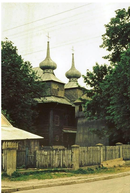
Ryc. 32. Kościół Rzymskokatolicki pw. Zwiastowania Najświętszej Maryi Panny - stan obecny
