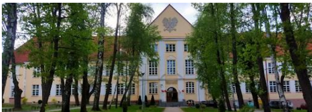
Budynek Szkoły, ob. Zespół Szkół nr 2 (Żwirki i Wigury 3)
