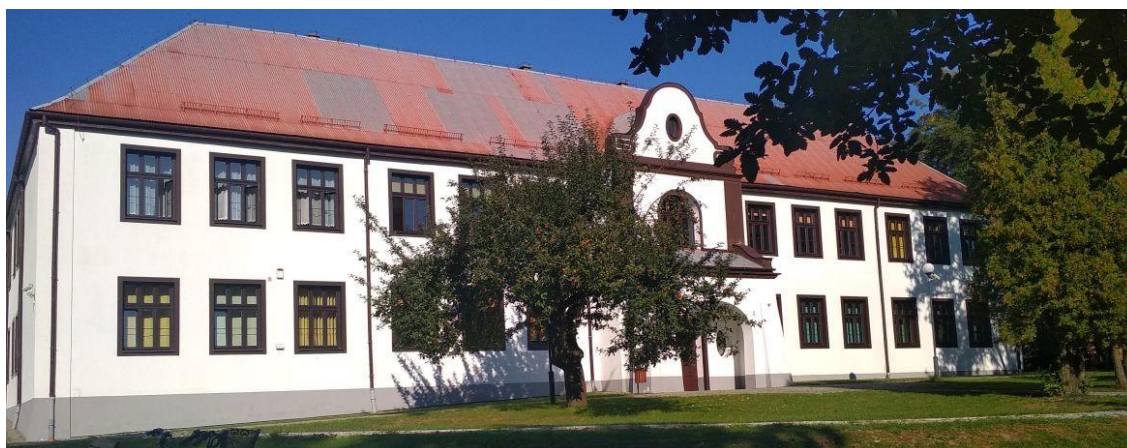
Ryc 42 Budynek szkoły podstawowej - stan obecny
