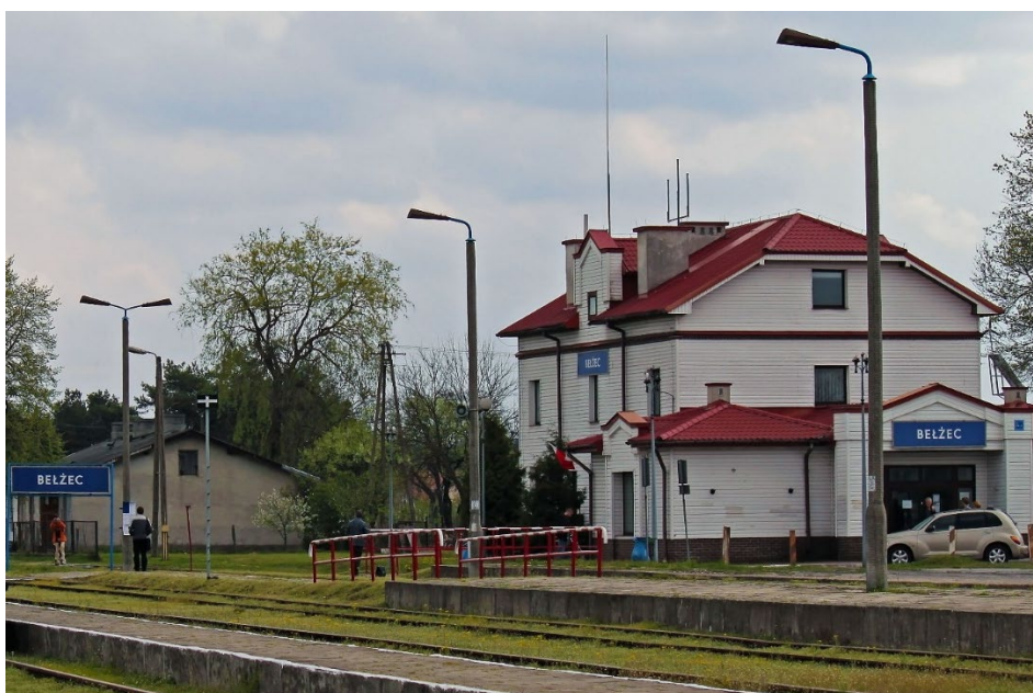
Ryc. 85. Stacja kolejowa w Bełżcu – potencjalnie jeden z kluczowych punktów dla połączeń kolejowych obszaru Partnerstwa
